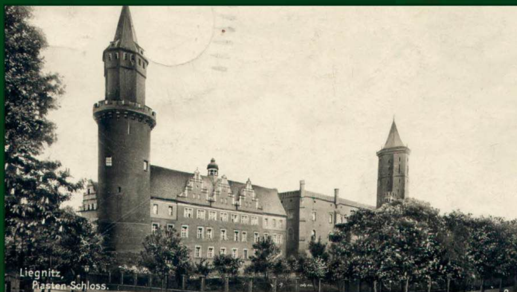
Widok zamku od strony południowo-wschodniej, po przebudowie neorenesansowej na początku XX wieku. Karta pocztowa ze zbiorów Muzeum Miedzi w Legnicy.
