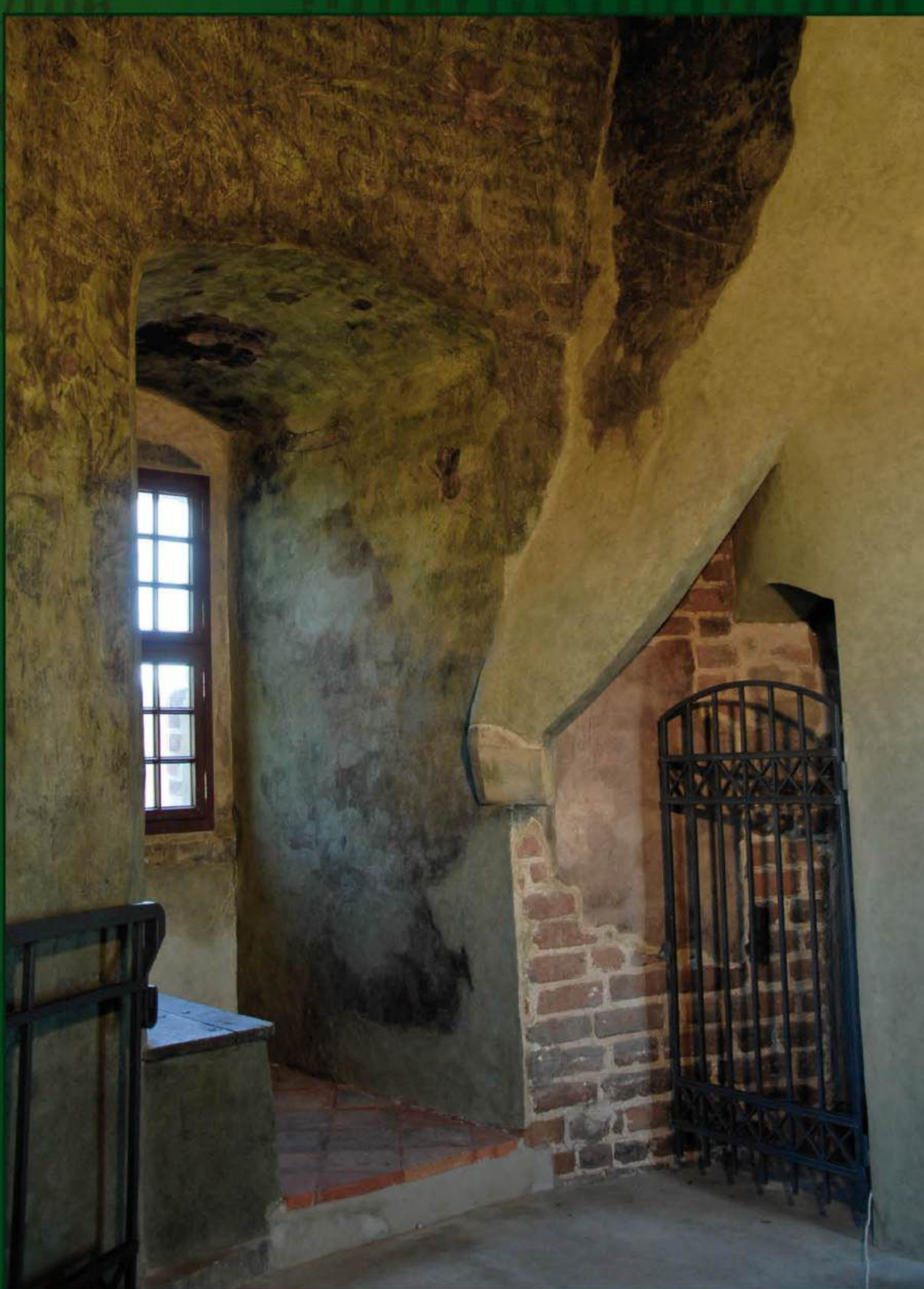
Fragment komnaty Św. Jadwigi - wyjście na schody biegnące w górę z komnaty na krenelaż. W tej części wieży odcinek klatki schodowej został zachowany. Połdenny był on jednak znacznej przebudowie. W latach 60-tych XX wieku, podczas prac remontowych, wejście na klatkę schodową przeniesiono z niższej północnej na miejsce zlikwidowanego kominka. Po lewej stronie, na ścianie między wnókami, widoczna sylwetka Dietricha von Bern. Fot. G. Spahn, 2013 r.
