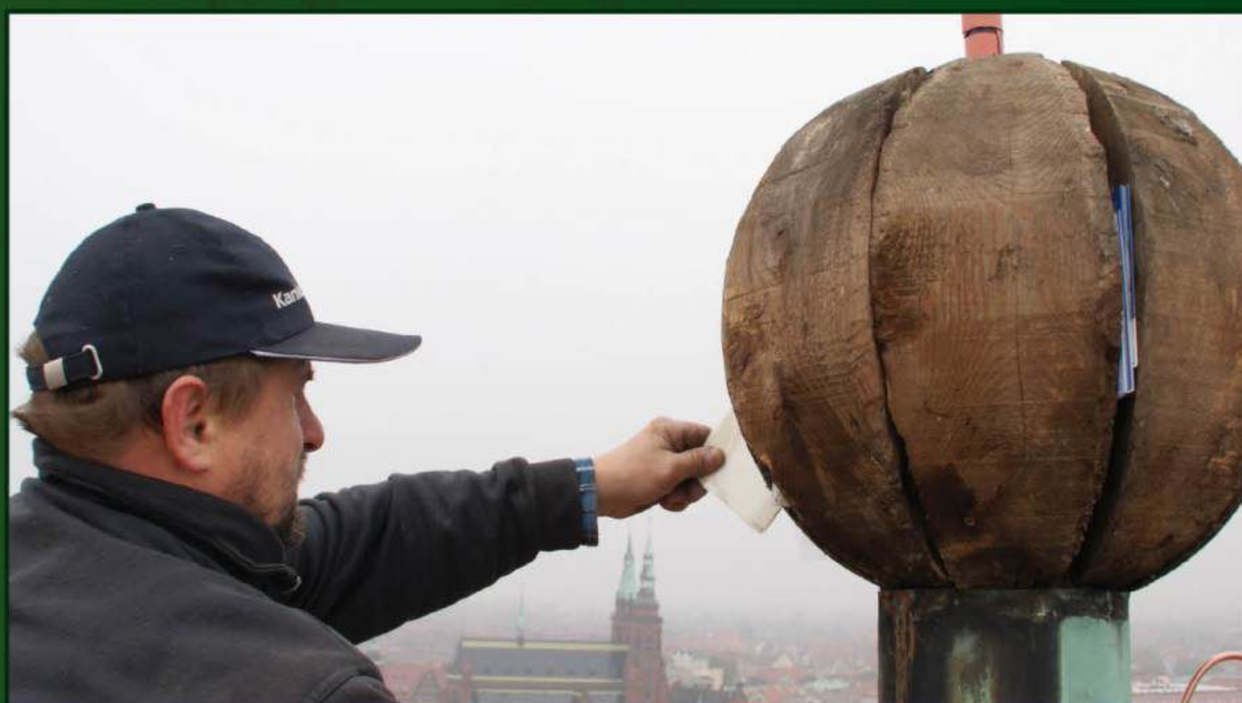
Montaż kuli wieńczącej hełm wieży św. Jadwigi. Fot. P. Krzyżanowski
