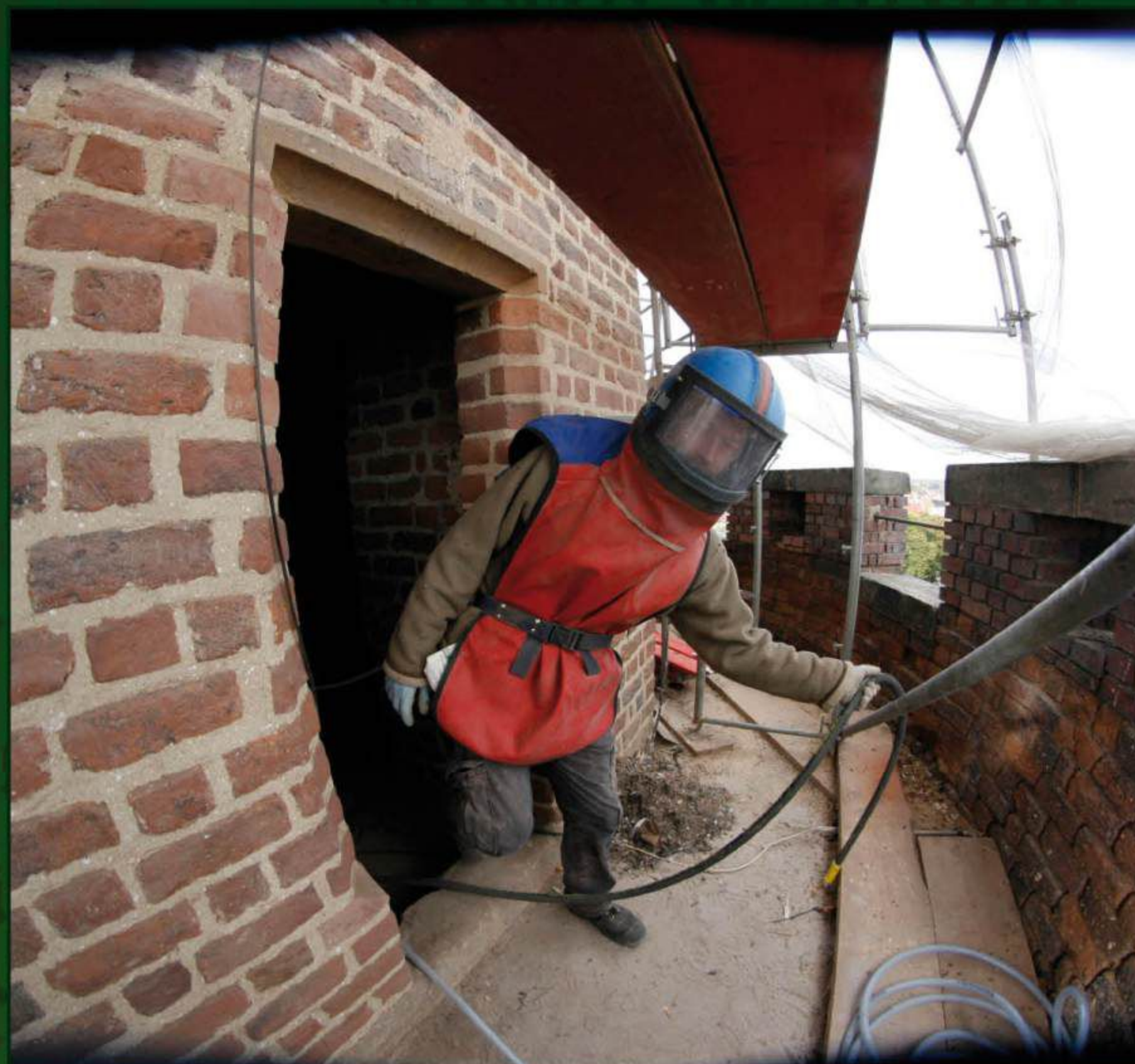
Widok na galerijkę wieży świętej Jadwigi podczas remontu. Fot. P. Krzyżanowski
