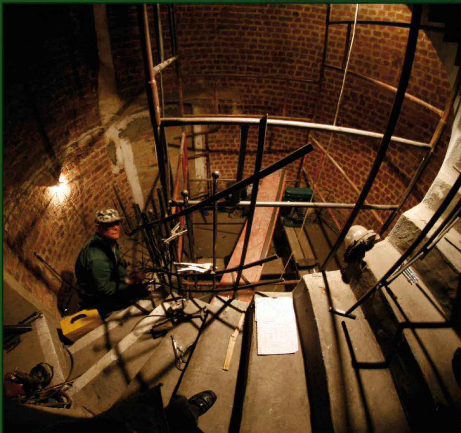
Widok wnętrza wieży świętej Jadwigi podczas remontu. Fot. P. Krzyżanowski
